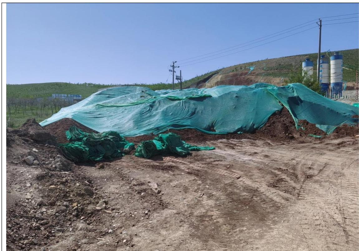
图 3.7-2 主体已实施的防尘网苫盖措施照片
