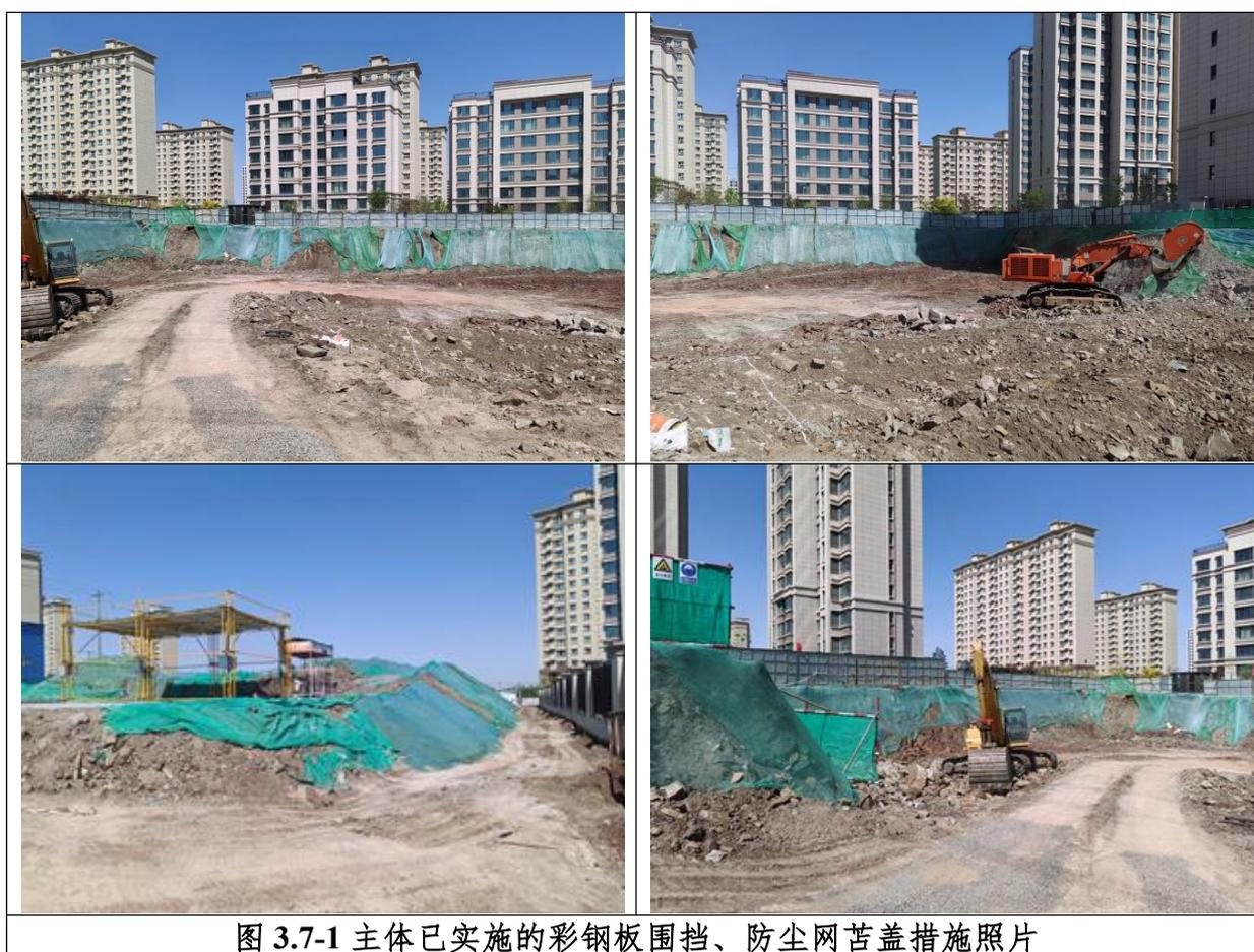
图 3.7-1 主体已实施的彩钢板围挡、防尘网苫盖措施照片
