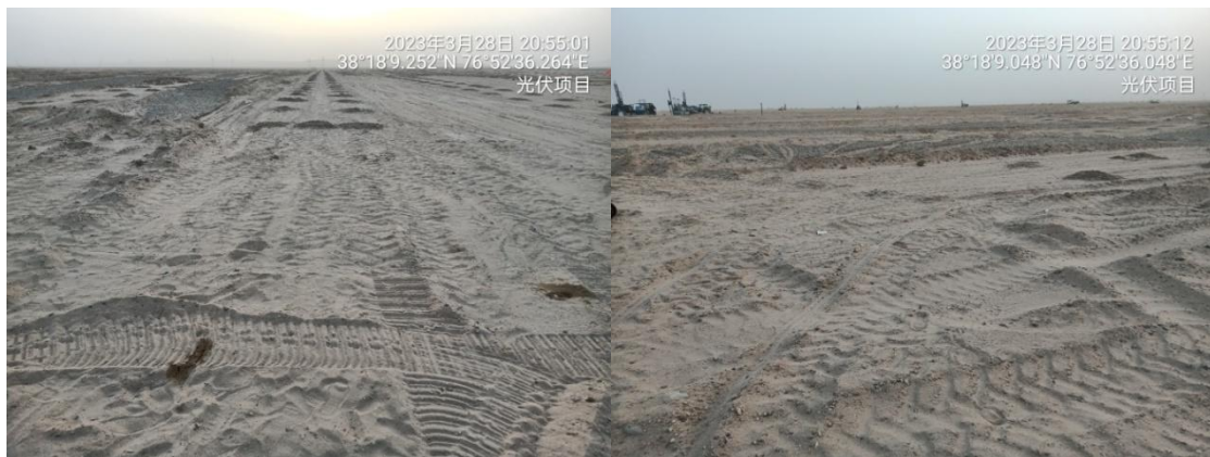
光伏阵列区土地平整
