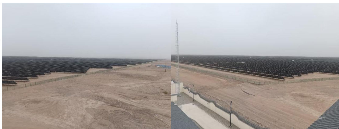
光伏阵列区建成后
