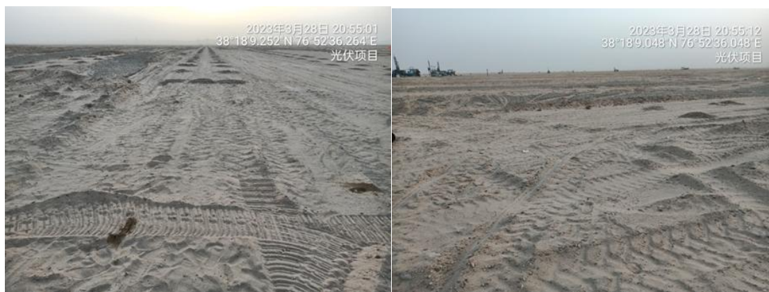
光伏阵列区土地平整
