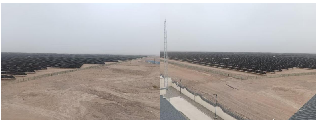
光伏阵列区建成后 图3.5-1工程措施现场照片
