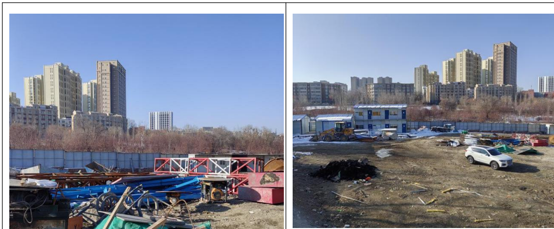
图 3.2-1 主体已实施的彩钢板围挡照片
